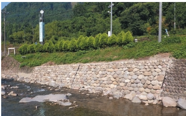
【写真】宝珠山川 石積護岸
