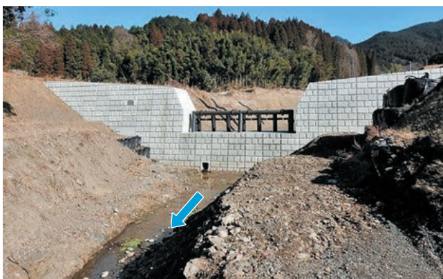
【写真】大黒川1号堰堤
