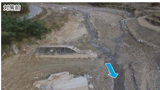
【写真】北川301号砂防堰堤
