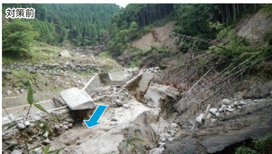
【写真】白木谷川砂防堰堤
