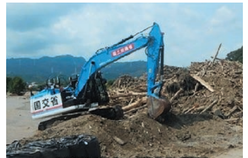
【写真】土砂や流木の撤去に着手 H29.8.15
