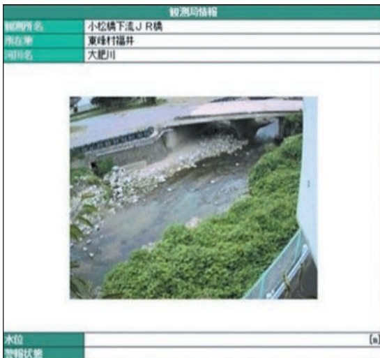
【図】簡易監視カメラの映像(小松橋下流JR橋)
