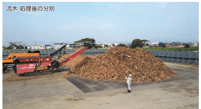
【写真】流木の分別処理状況
