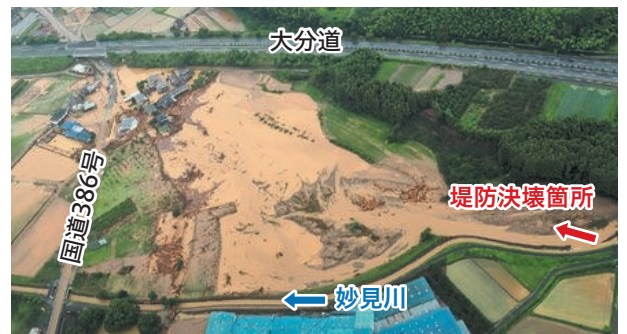
【写真】堤防決壊した妙見川(朝倉市須川)
