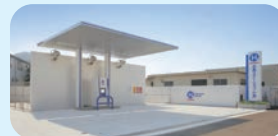
水素ステーション
