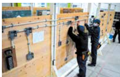
合成樹脂管工工作業
