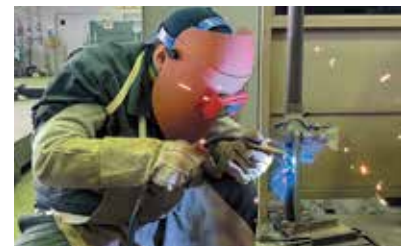
半自動溶接作業
