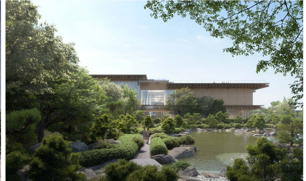
東面（日本庭園側）
