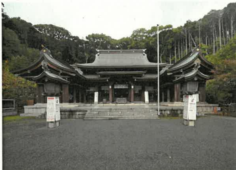
写真1 拝殿・渡廊・祭舎 (南から)
