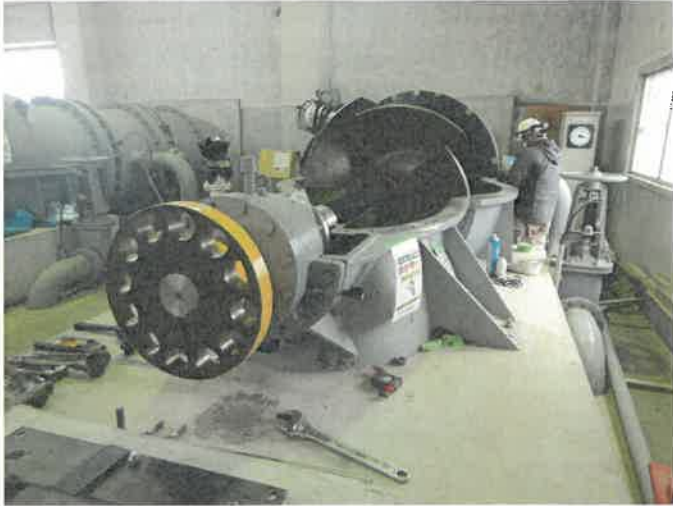
排水機場の整備(岡垣町)
