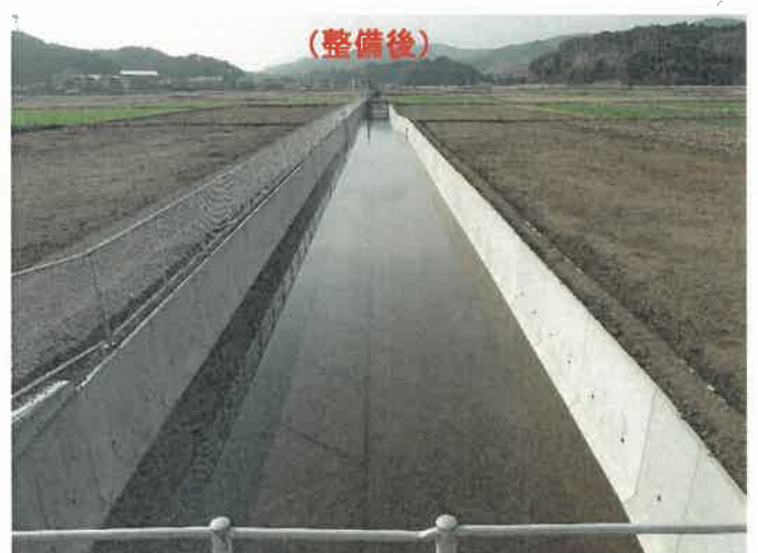
老朽化した排水路の整備(遠賀町)
