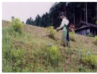
【急傾斜法面での草刈り作業】
