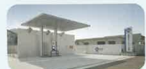
水素ステーション
