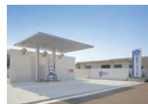
水素ステーション
