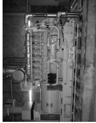
(左：県本庁舎地下非常用電源設備、右：県本庁舎10階バックアップ非常用電源設備)
