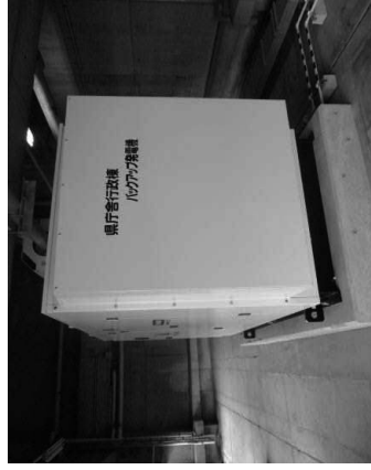
(左：県本庁舎地下非常用電源設備、右：県本庁舎10階バックアップ非常用電源設備)
