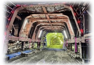
<国道322号嘉麻バイパス(トンネル)>
