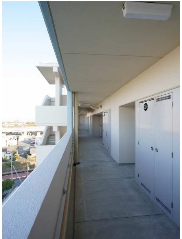
【代表住戸(玄関ポーチ)】
