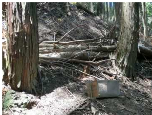
土砂受け箱設置状況(簡易木柵工の直下)
