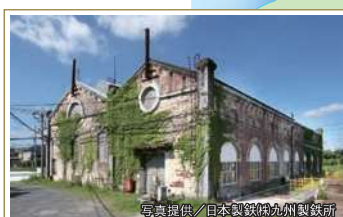
1910年以来、現在も動き続けている製鐵所の送水施設
