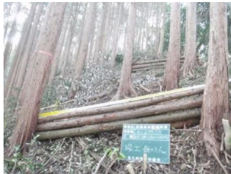
簡易木柵工の設置状況
