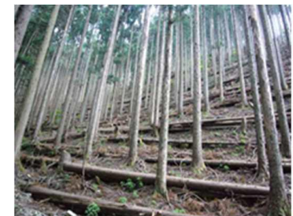
設置された筋工
