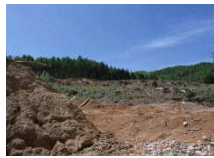
住宅地造成のための森林伐採
