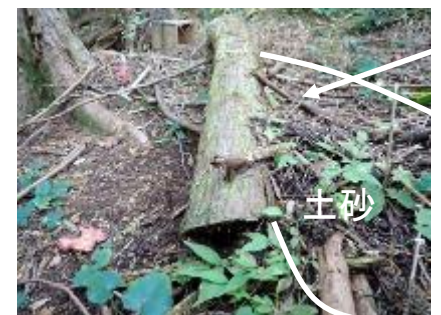
(簡易木柵工の土砂移動抑制状況)
