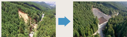
▲平成30年7月豪雨 道路の復旧状況(飯塚大野城線)
