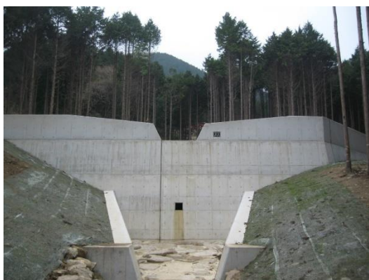
[治山ダム工 (谷止工、床固工)]
