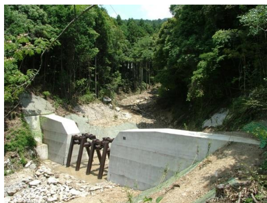
[治山ダム工 (スリットダム工)]
