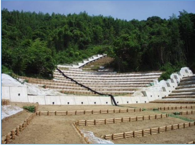
[地すべり防止工（アンカー工）]
