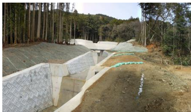
[護岸工、流路工]
