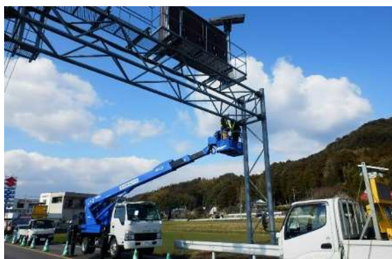
高所作業車による定期点検の様子
