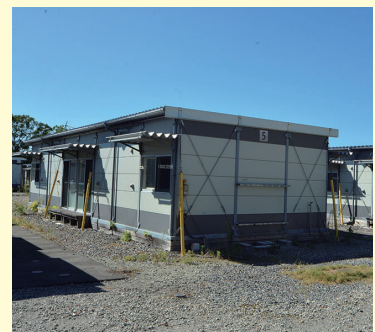
運動場に建てられた仮設住宅
