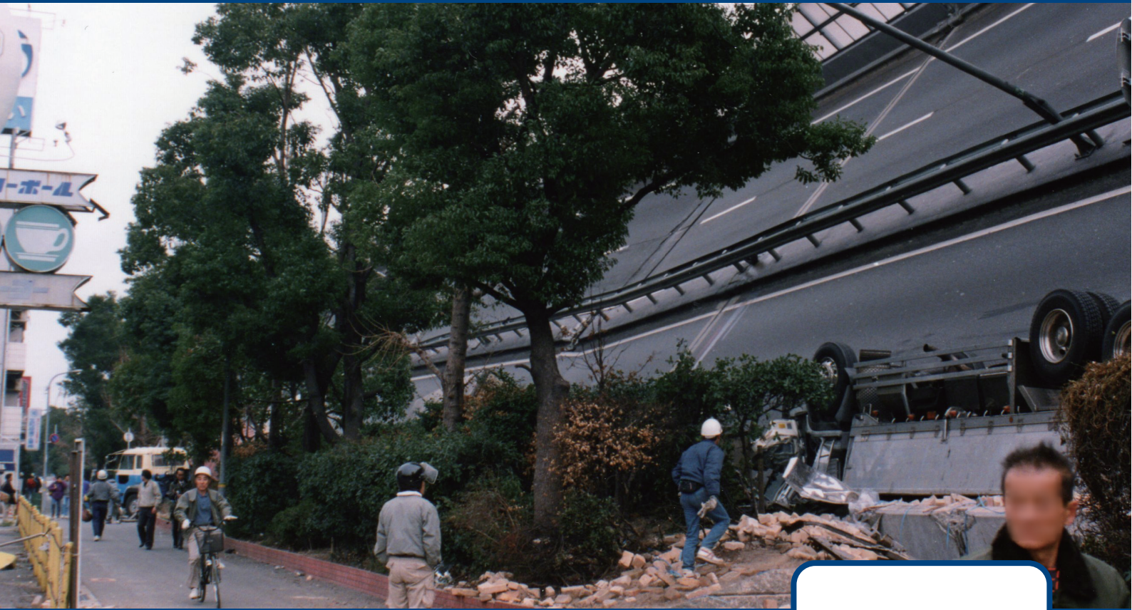
平成7年1月兵庫県神戸市東灘区、阪神淡路大震災で倒壊した阪神高速道路(画像提供:神戸市)
