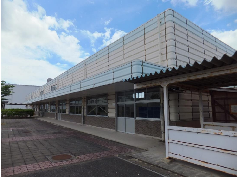
全景（実習棟A）
