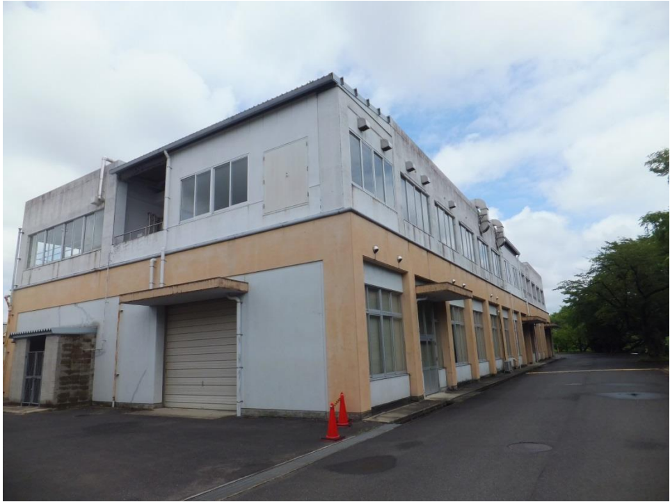
全景（実習棟A）
