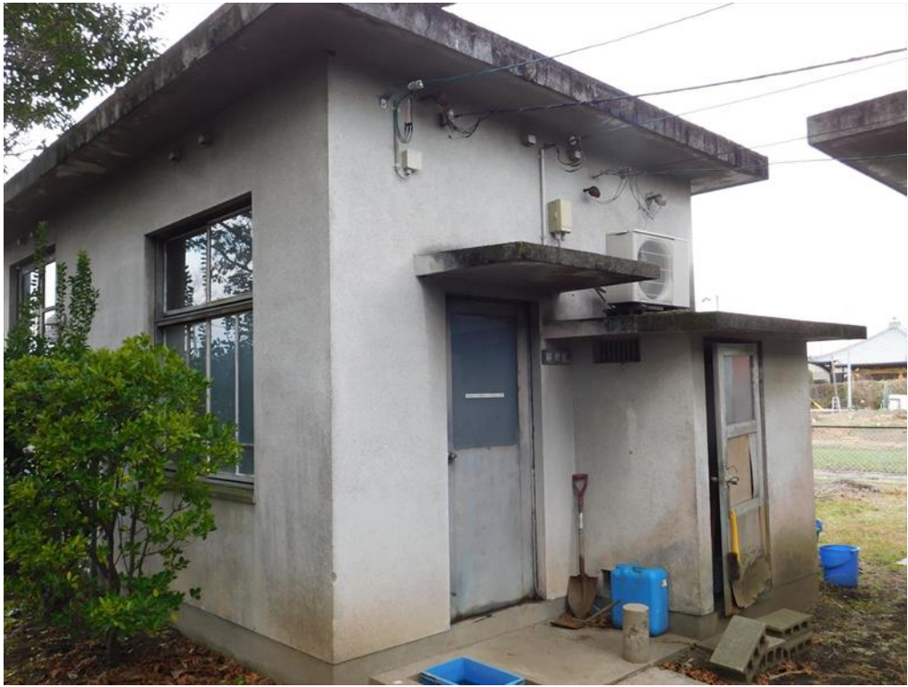
全景（試験・研究棟）
