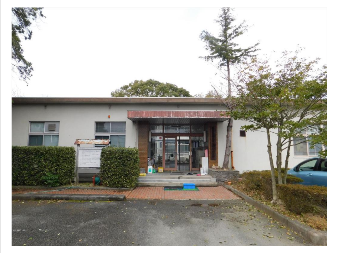
全景（庁舎・事務所）
