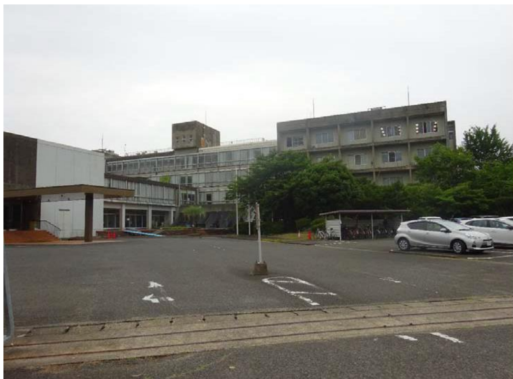
全景（事務所・研究棟）
