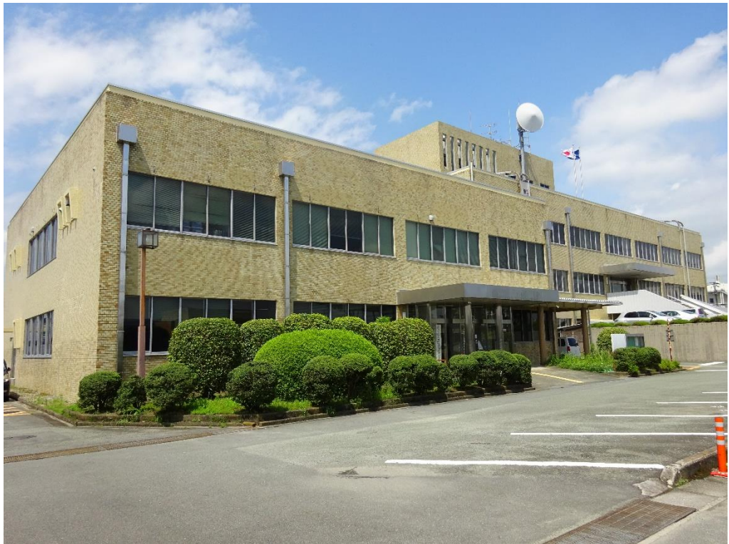
全景（保健所棟）
