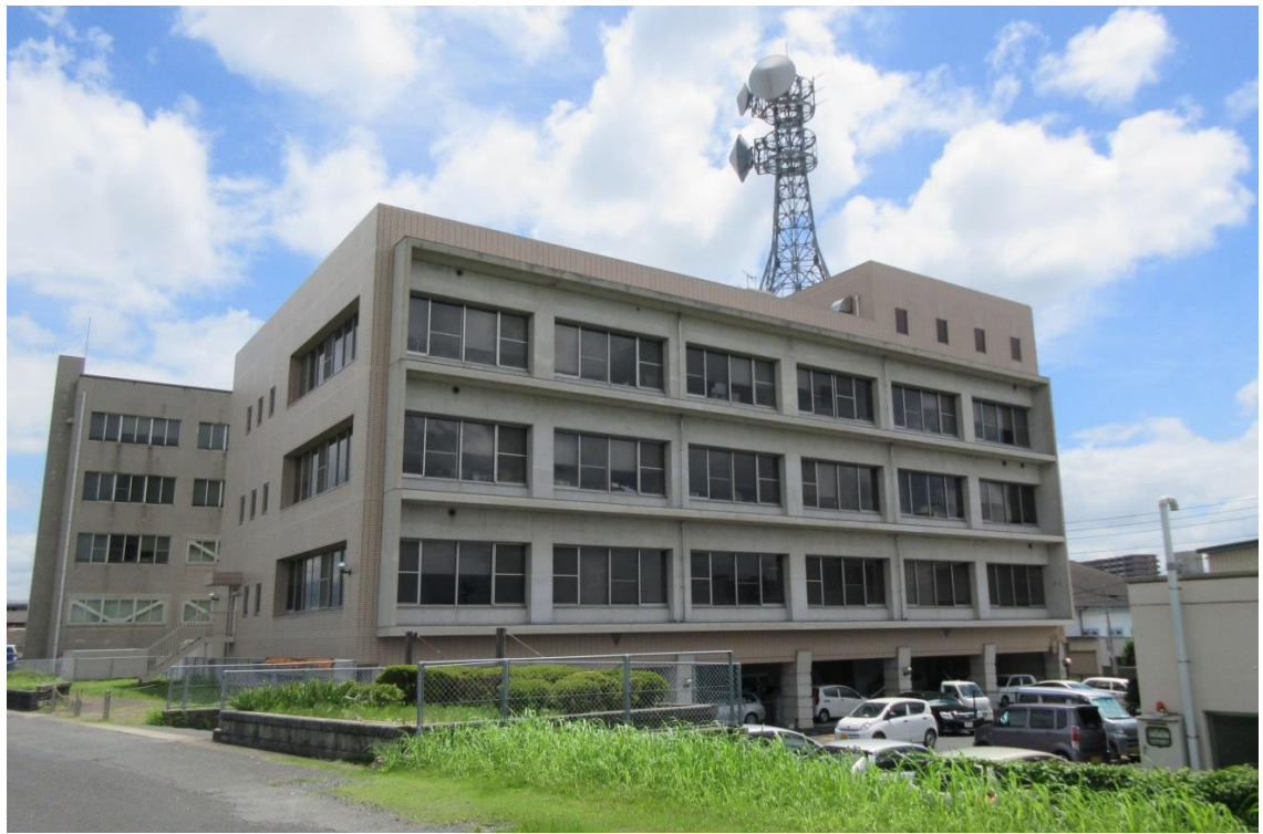
全景（県土整備事務所棟）
