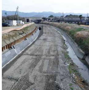
▲河川の改良工事
