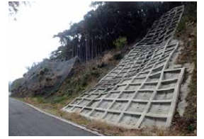
▲道路法面の崩壊対策
