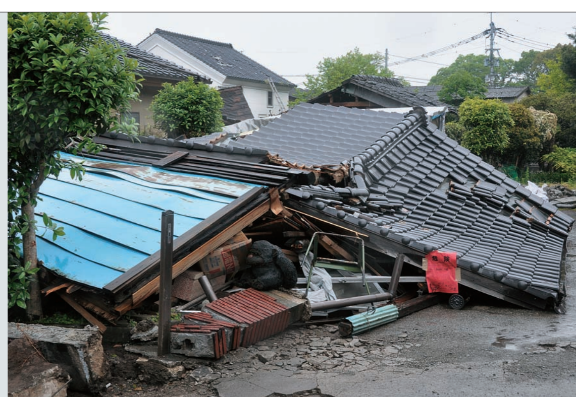
完全に倒壊した家屋（益城町）
