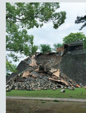
石垣が完全に崩れた熊本城（熊本市）
