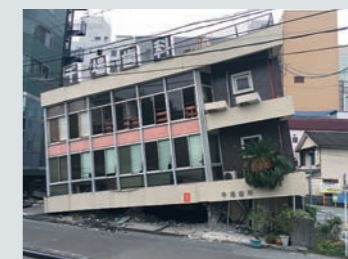
大きなビルも倒壊（益城町）
