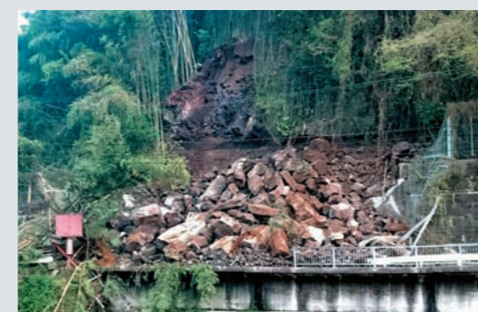
福岡県内でも崩落による通行止めなどの人的、家屋、道路などの被害を受けた（八女市矢部地区）
