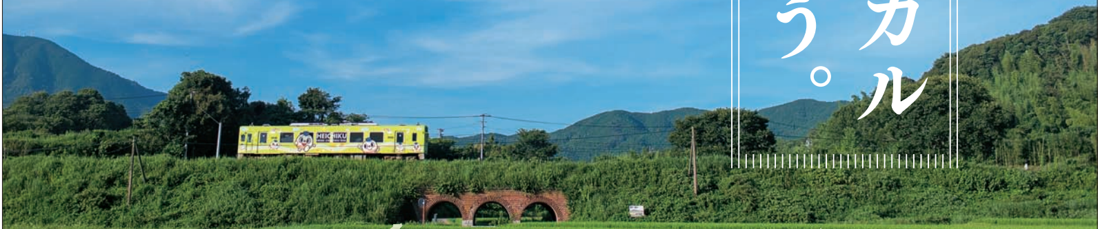
国登録有形文化財(建造物)である内田三連橋梁を走る車両(平成筑豊鉄道)
